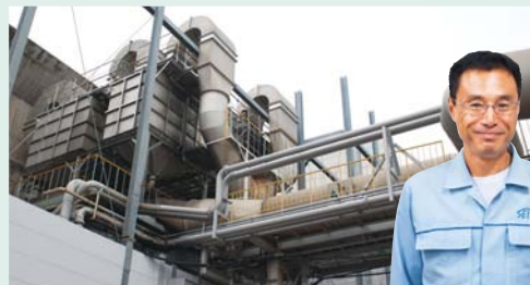
排气净化设备
