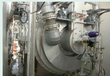
蒸发浓缩式废液减容化装置
