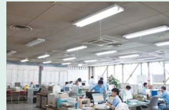
安装高效率荧光灯并将开关改成拉绳式
