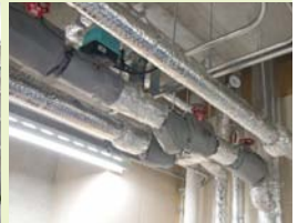
蒸汽管道的散热对策
