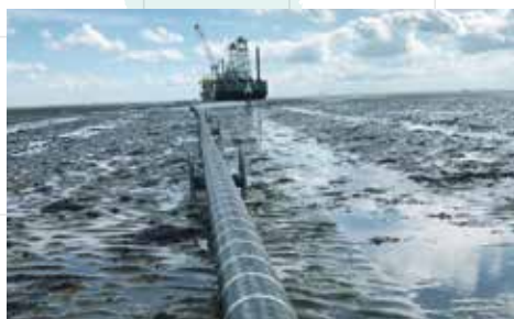
敷设海底电缆的情景
