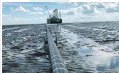
敷设海底电缆的情景
