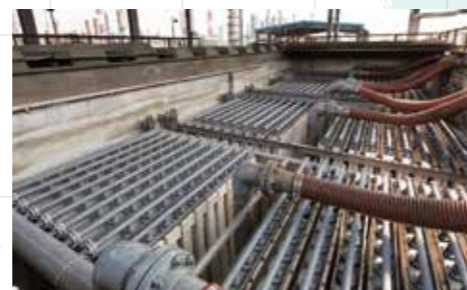
被台湾大型石油精制企业所引进的水处理设备
