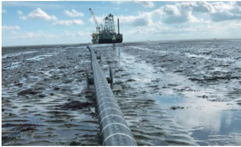
敷设海底电缆的情景
