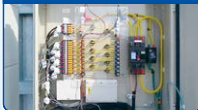
电力线通信 (PLC)
