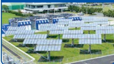
聚光型太阳能发电装置 (CPV)
