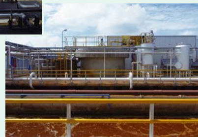
泰国工厂的污水处理装置
